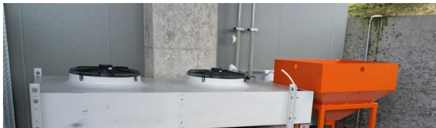
Figura 2. Aerorrefrigerador (esquerda) e silo de biomassa (direita).
