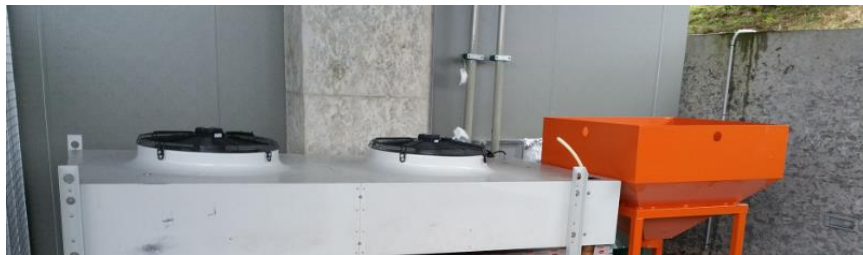
Figura 2. Aerorefrigerador (izquierda) y silo de biomasa (derecha).
